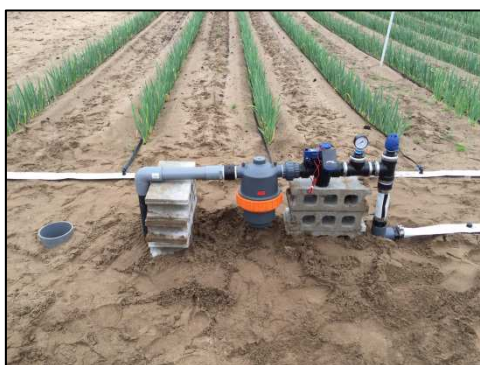
点滴灌水装置の設置状況
