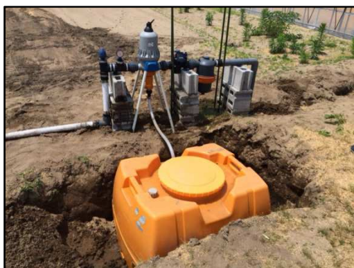
点滴灌水装置の設置状況
