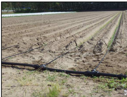
点滴灌水装置の設置状況
