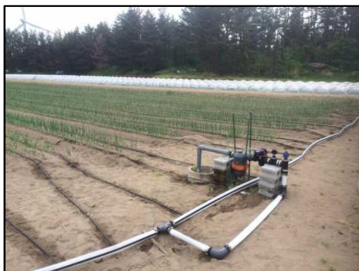
点滴灌水装置の設置状況
