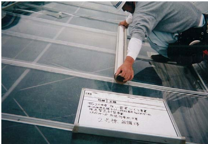
外張りフィルムの複層化工事
