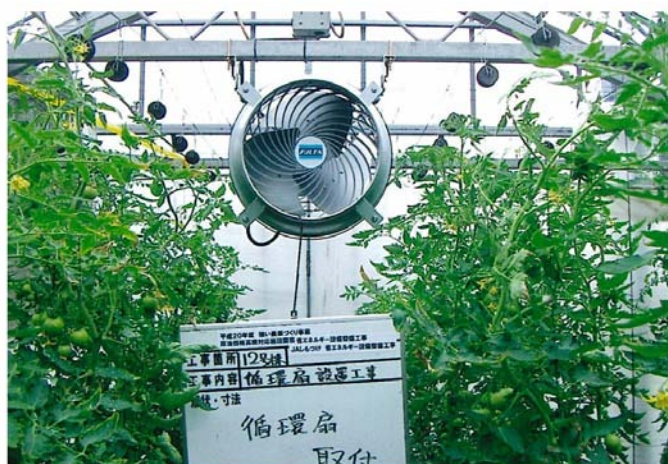
循環扇の設置
