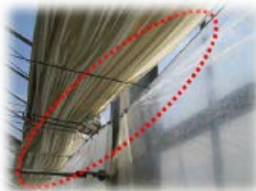
天井カーテンと側面カーテンのつなぎ目
